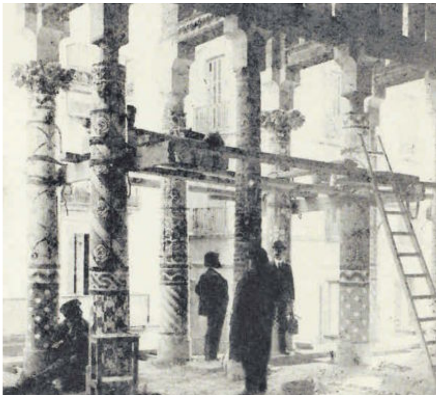
Construcció de les columnates del Palau de la Música Catalana, a principis del segle XX.
